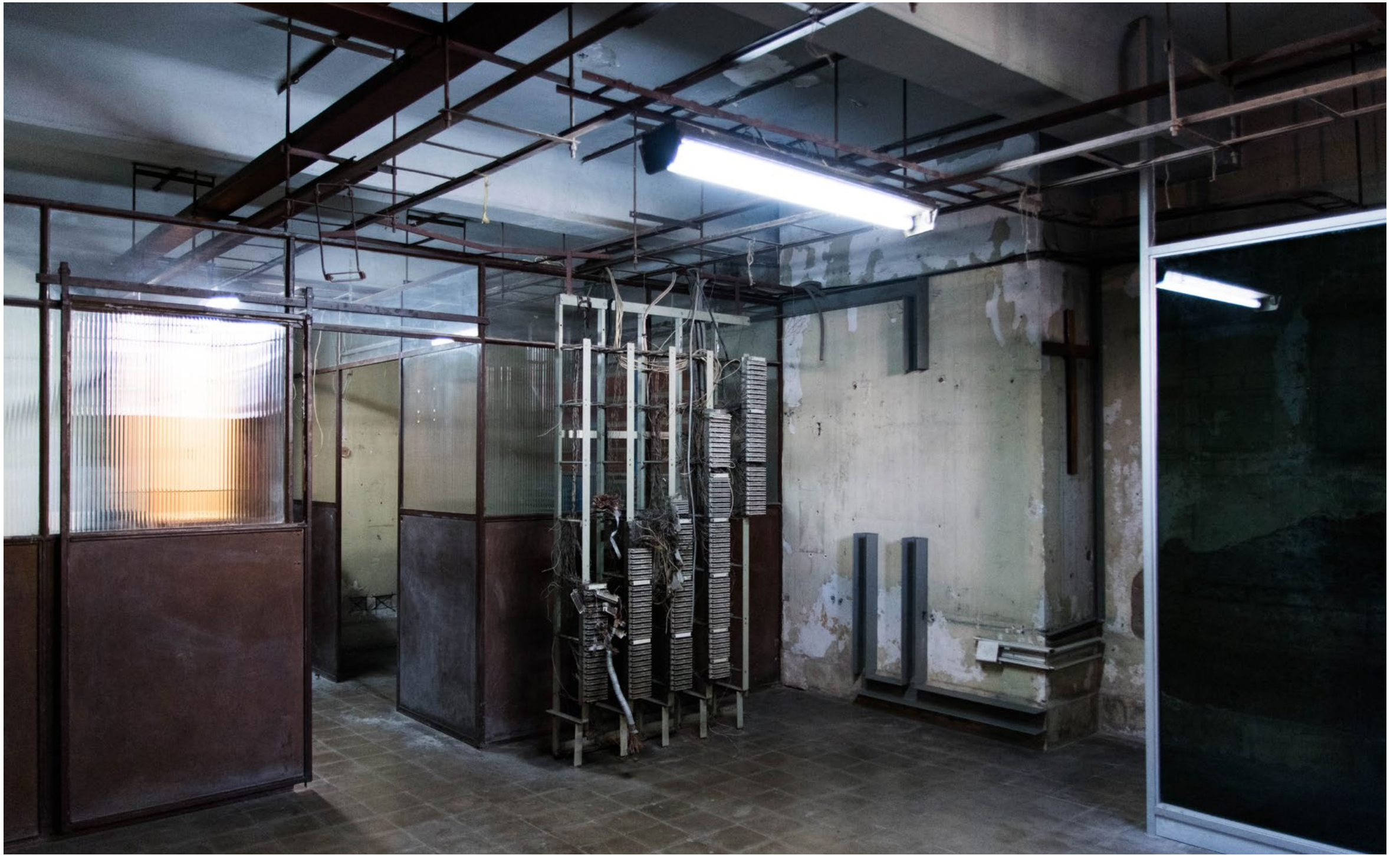
Sala de espionaje telefónico de la Central Nacional de Informaciones (CNI). Espacio intervenido por los artistas. Desde este espacio se sube la energía eléctrica a las salas de exposición del segundo piso.
